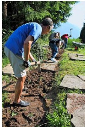
Jugendliche und Kiwaner beim Ausbessern des Natursteinwegs. jss
